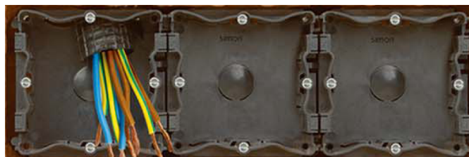
FIGURA 1.1. Exemple de 3 caixes universals encastades
