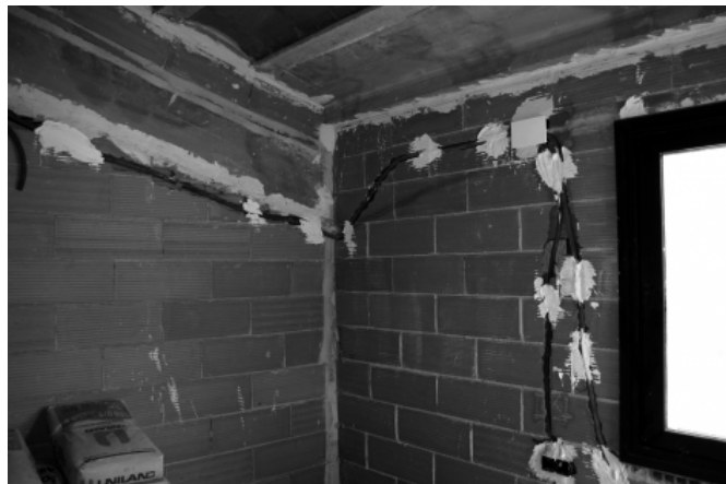
FIGURA 2.10. Exemple instal·lació encastada en parets d'obra
