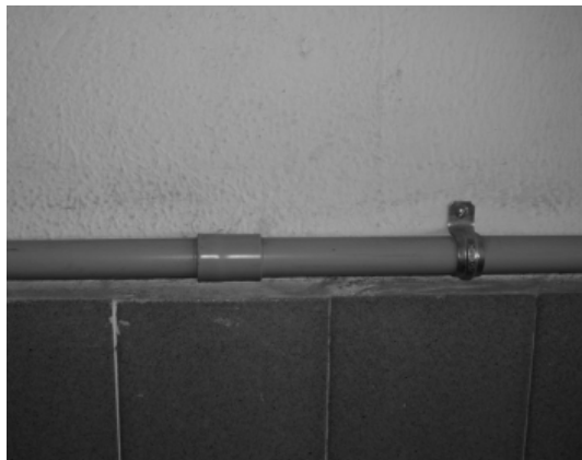
FIGURA 2.11. Accessoris per a tubs. Ús d'un accessori perquè la protecció del tub sigui efectiva.
