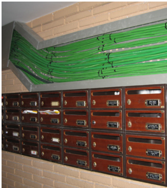
FIGURA 1.34. Derivacions individuals a l'interior de canals protectores
