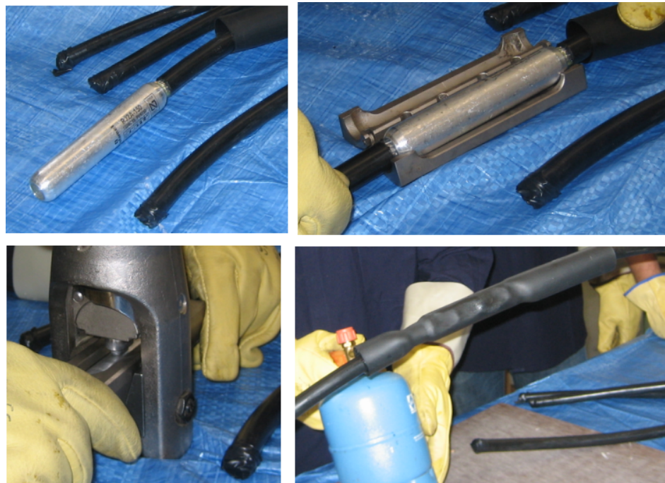
FIGURA 2.14. Procés d'execució de l'empalmament amb maniguet termoretràctil
