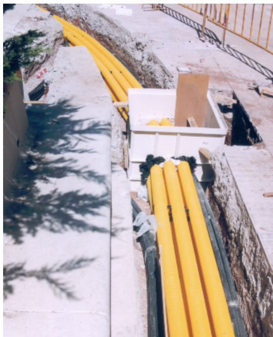
FIGURA 4.16. Una serie de canalitzacions entubades
