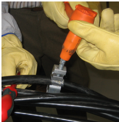
FIGURA 2.13. Connexió amb connector de pressió cargol de fusió
