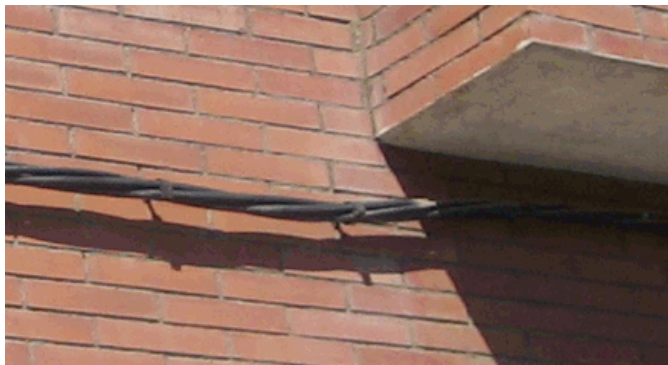
FIGURA 1.3. Xarxa trenada posada
