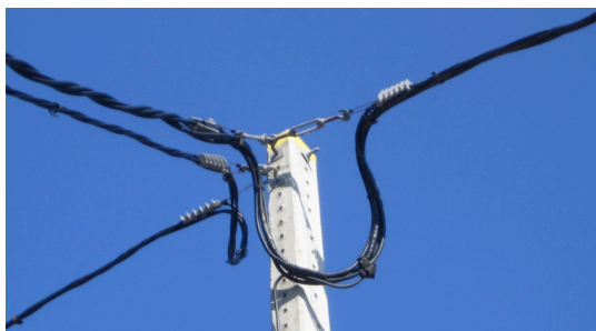
FIGURA 1.4. Xarxa trenada tibant en suport de formigó
